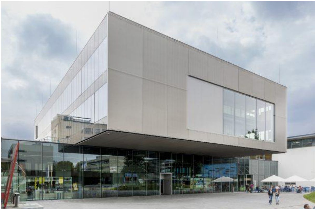
Abbildung 2: Außenansicht des interdisziplinären Lehr- und Lerngebäudes PULSE. Quelle: https://campusdevelopment.tu-delft.nl/en/project/pulse/ (09.06.2020)
