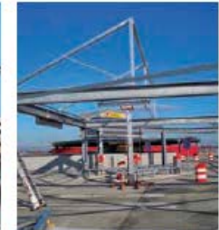
Montage der Photovoltaikanlage auf dem Parkhausdach
