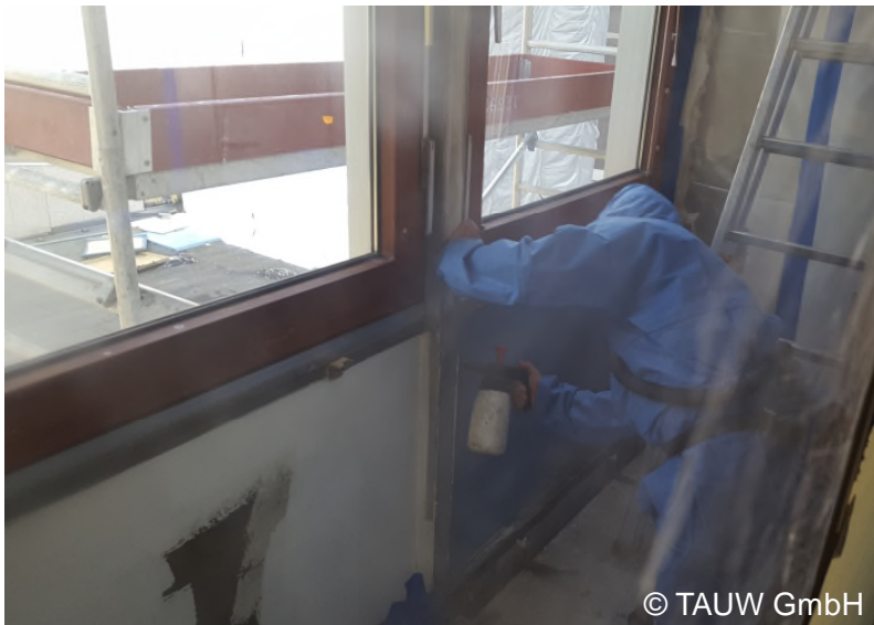
Feinreinigung optional mit Einsatz von Restfaserbindemittel
