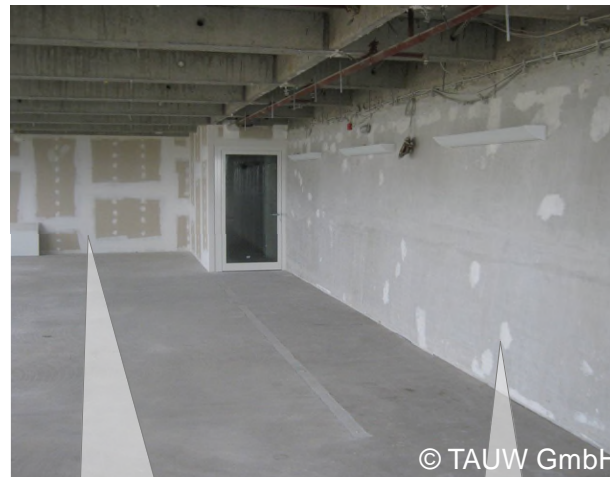
Neue GK-Trennwand Fugenfüller / Spachtel
