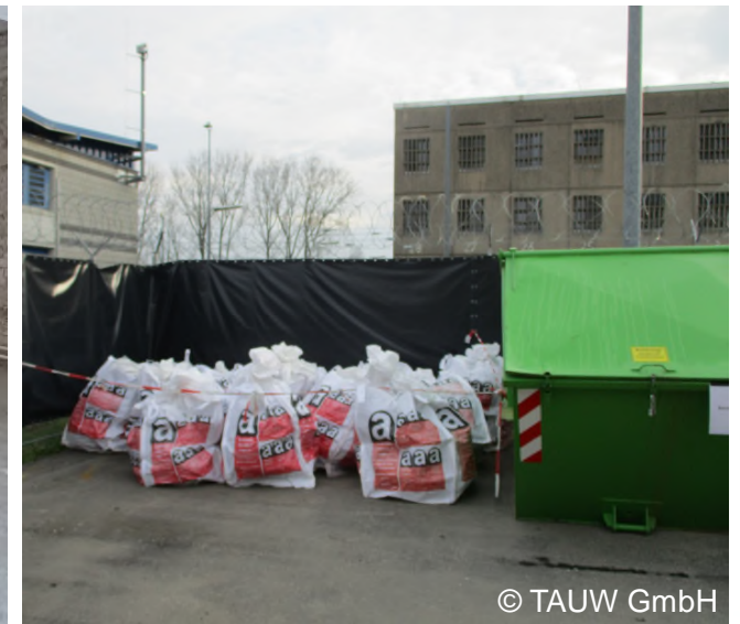
Getrennte Entsorgung in verschließbaren und gekennzeichneten Behältnissen
