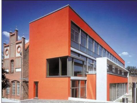
» Das Gebäude schließt mittels einer „Lichtfuge“ an die Brandwand eines bestehenden Backsteingebäudes aus dem 19. Jahrhundert an. Proportion und Größe des Neubaus orientieren sich am Bestand und ergänzen ihn durch ein modernes Gegenüber. Eine nahezu verschattungsfreie Südausrichtung wird durch die Lage des Grundstücks ermöglicht und unterstützt das energetische Planungsziel der natürlichen Belichtung und des minimalen Energieverbrauchs. «
