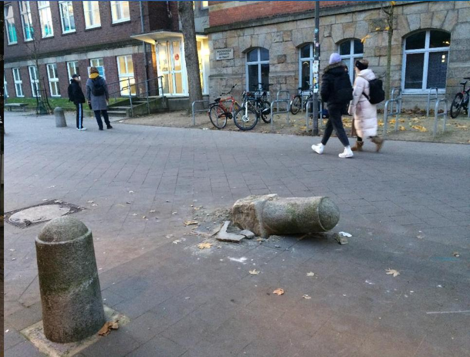
Die Slalom-Verkehrsführung führte zu Unfällen. Der Poller wurde 11-mal umgefahren, bis Reflektoren angebracht wurden
